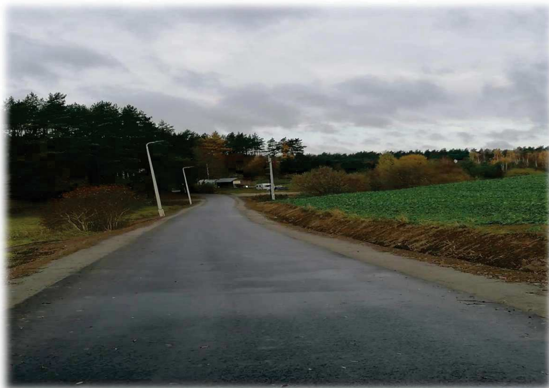
Zmodernizowana droga w miejscowości Czarne Małe.
